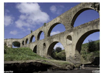
ARCOS DE SAN JUAN ARCOS OJOS DE AGUA
